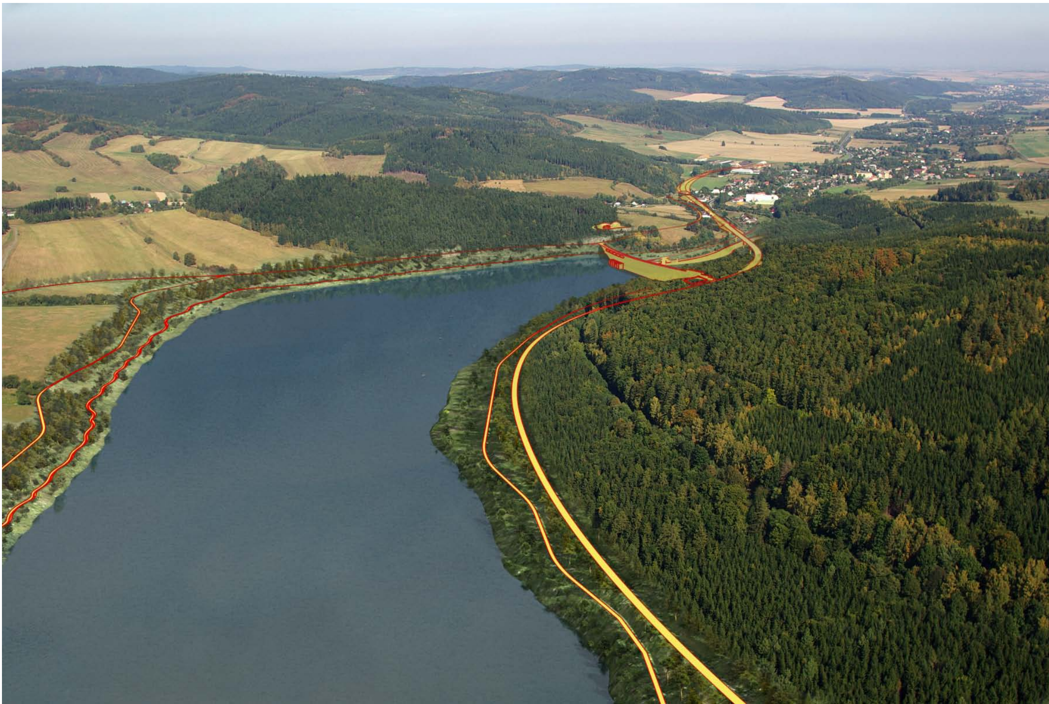
Vodní dílo Nové Heřminovy, letecký pohled po toku (vpravo nahoře obec Zátor) - po realizaci navrhovaných opatření (zvýrazněné kontury navrhovaných konstrukcí)
