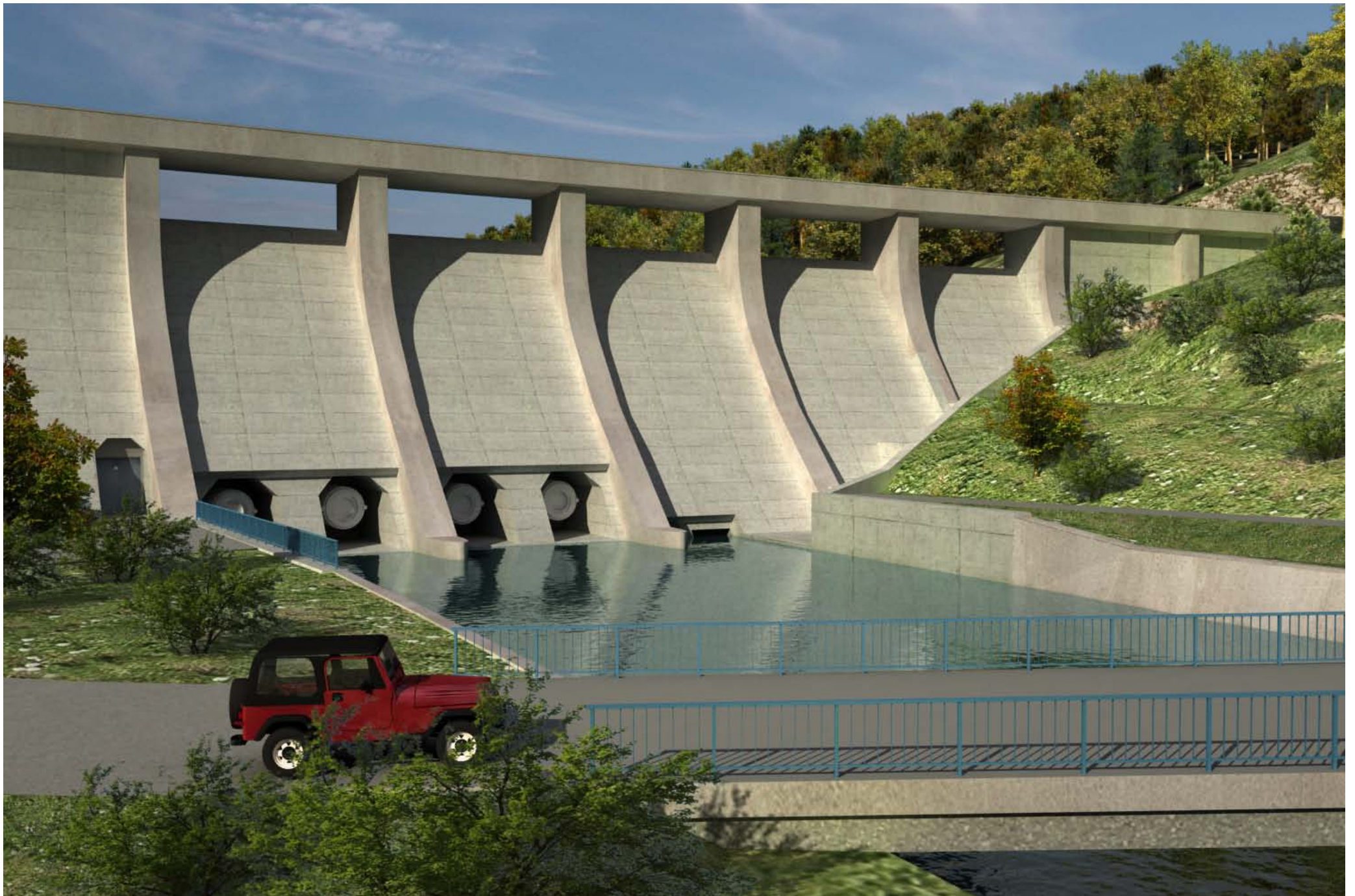
Vodní dílo Nové Heřminovy, pohled na vzdušní líc hráze a vývar
