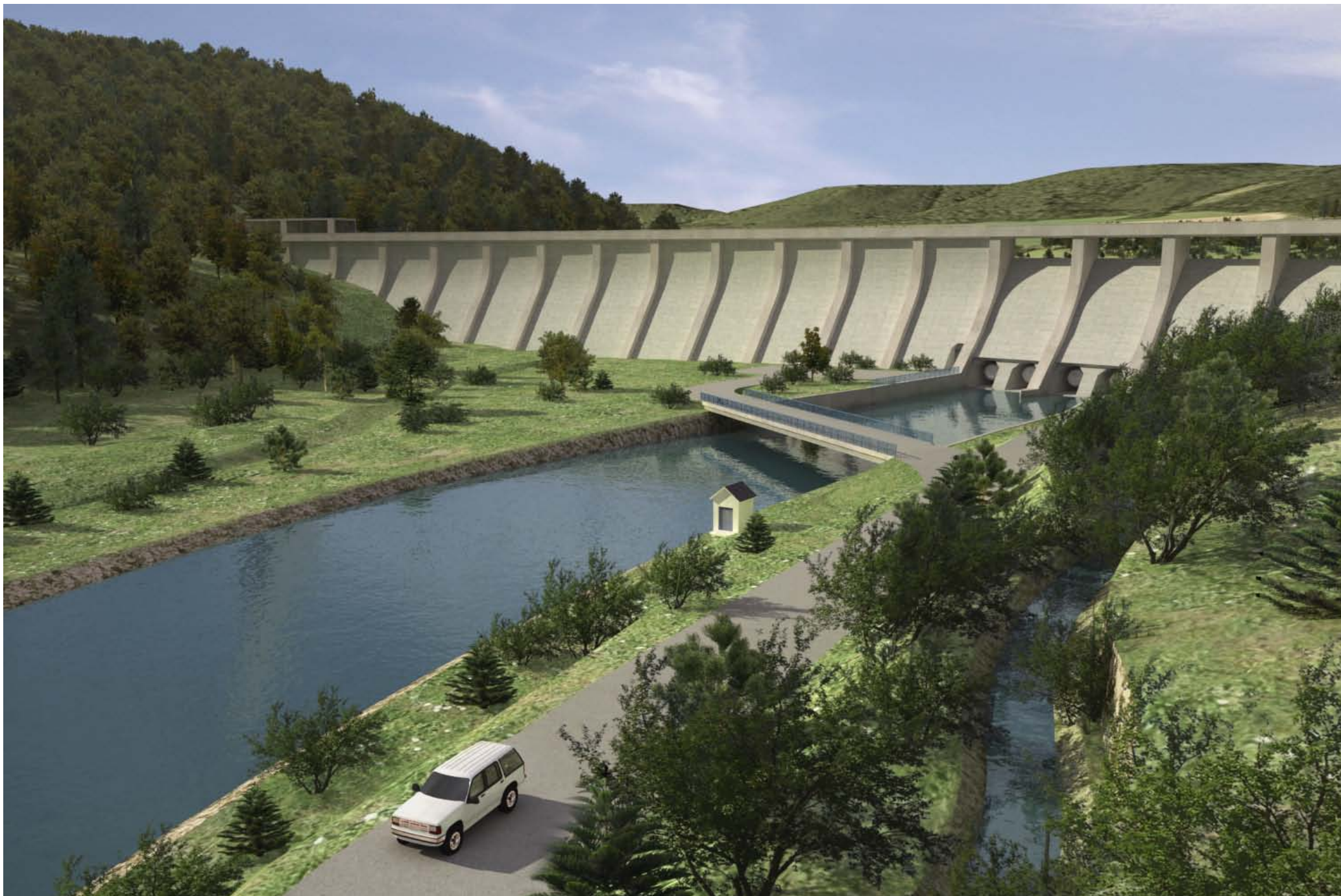
Vodní dílo Nové Heřminovy, pohled na hráz, podhrází, obtokové koryto
