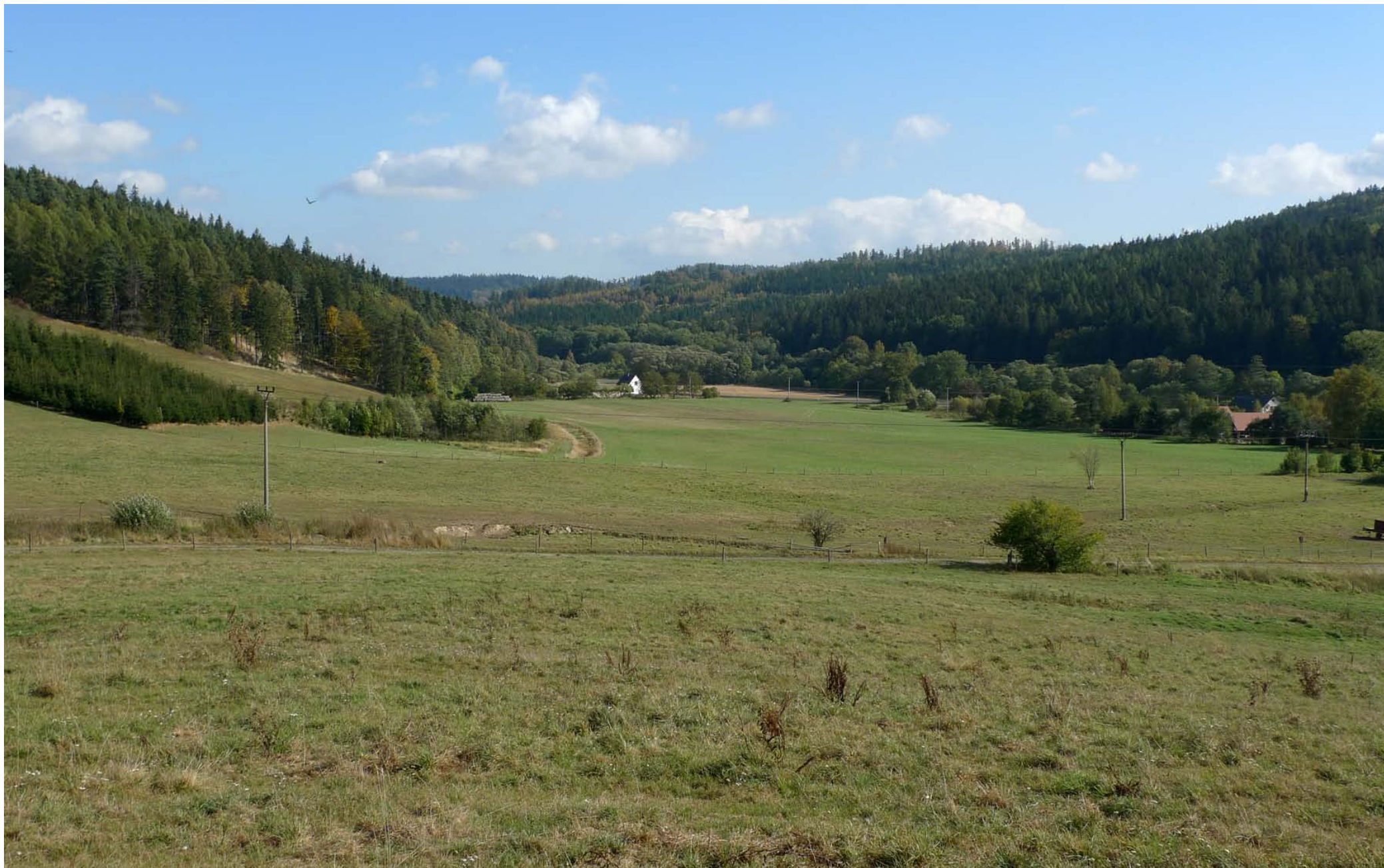
Vodní dílo Nové Heřminovy, pohled na hrázový profil z levého údolního svahu po vodě - současný stav
