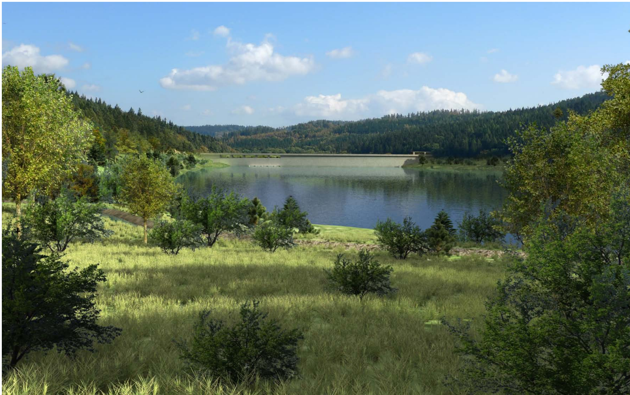
Vodní dílo Nové Heřminovy, pohled na hrázový profil z levého údolního svahu po vodě - po realizaci navrhovaných opatření
