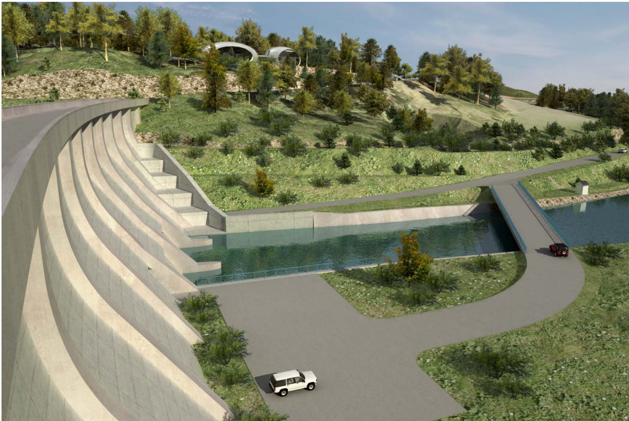
Vodní dílo Nové Heřminovy, pohled na hráz, podhrází a provozní středisko
