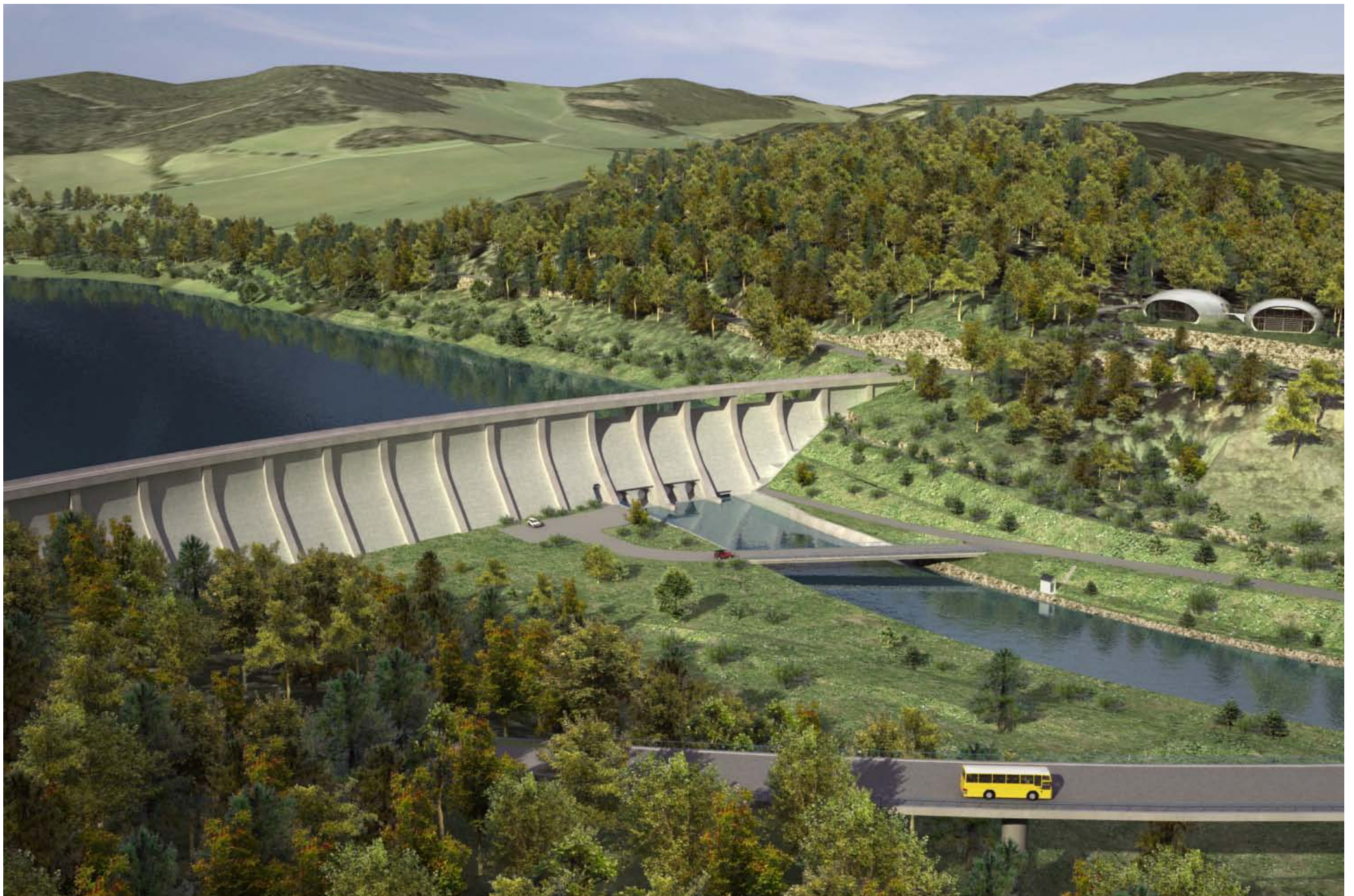
Vodní dílo Nové Heřminovy, letecký pohled na hráz a podhrází, provozní středisko, v popředí estakáda silnice I/45
