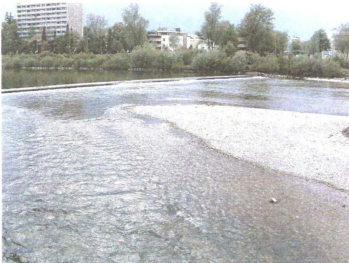
Obr. 3 Řeka Isar v Mnichově – začátek revitalizovaného úseku
