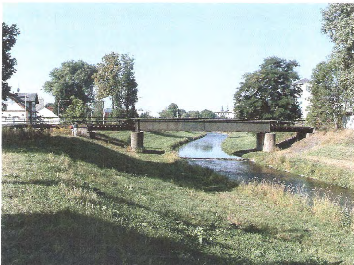
Obr. 1 Železniční most u nádraží
