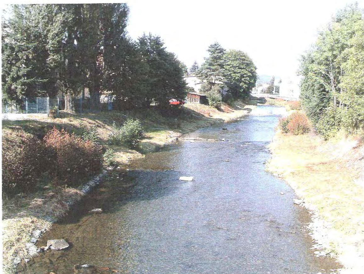
Obr. 7 Pohled z mostu Sokolovská proti proudu
