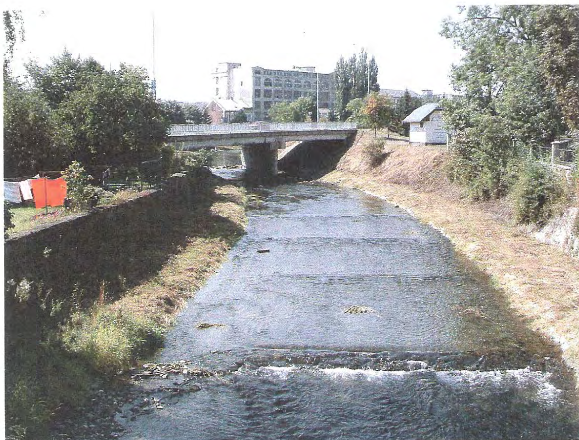
Obr. 5 Pohled z mostu Minoritů proti proudu na most Opavská
