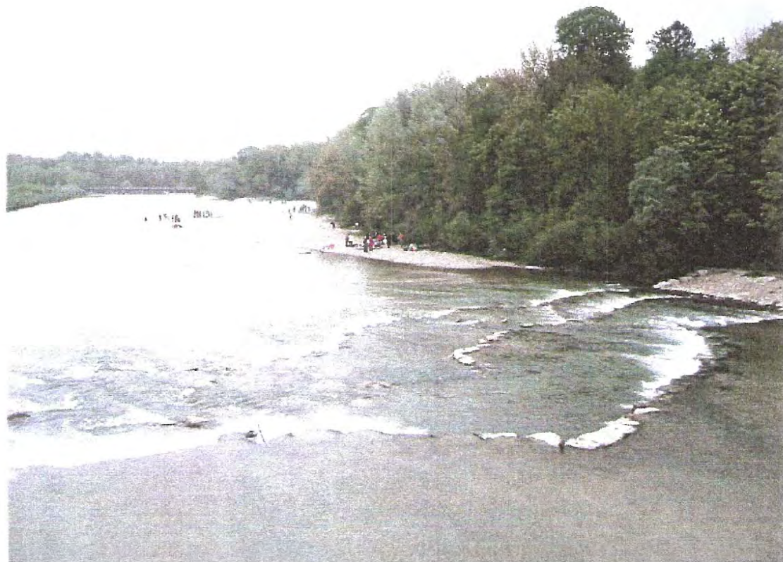
Obr. 2 Štěrkové břehy řeky Isar v Mnichově (po revitalizaci)
