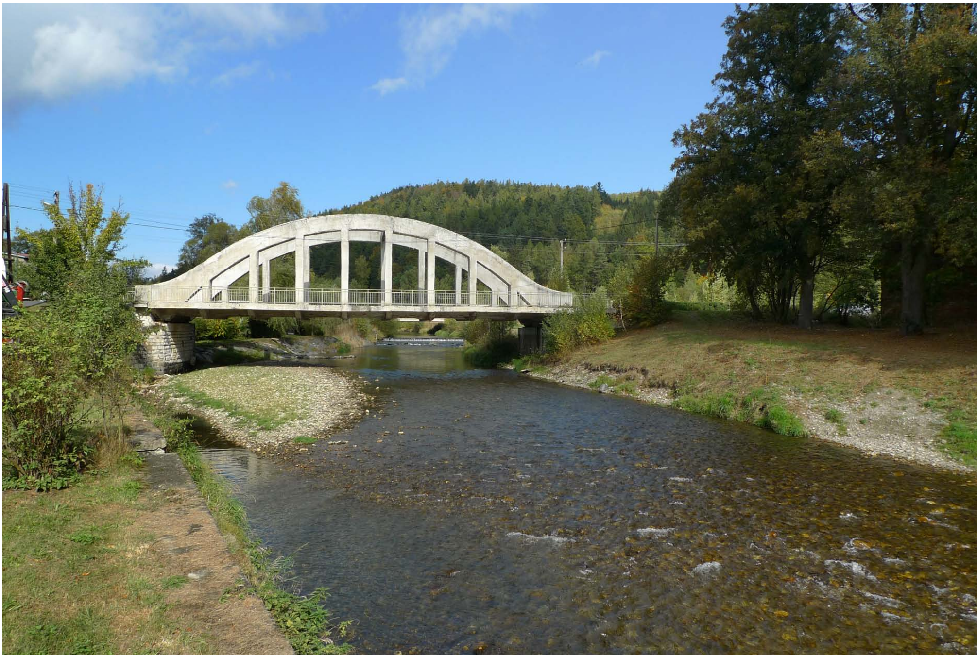
Obec Nové Heřminovy, pohled proti vodě na obloukový most (km 88.940 dle TPE) - současný stav
