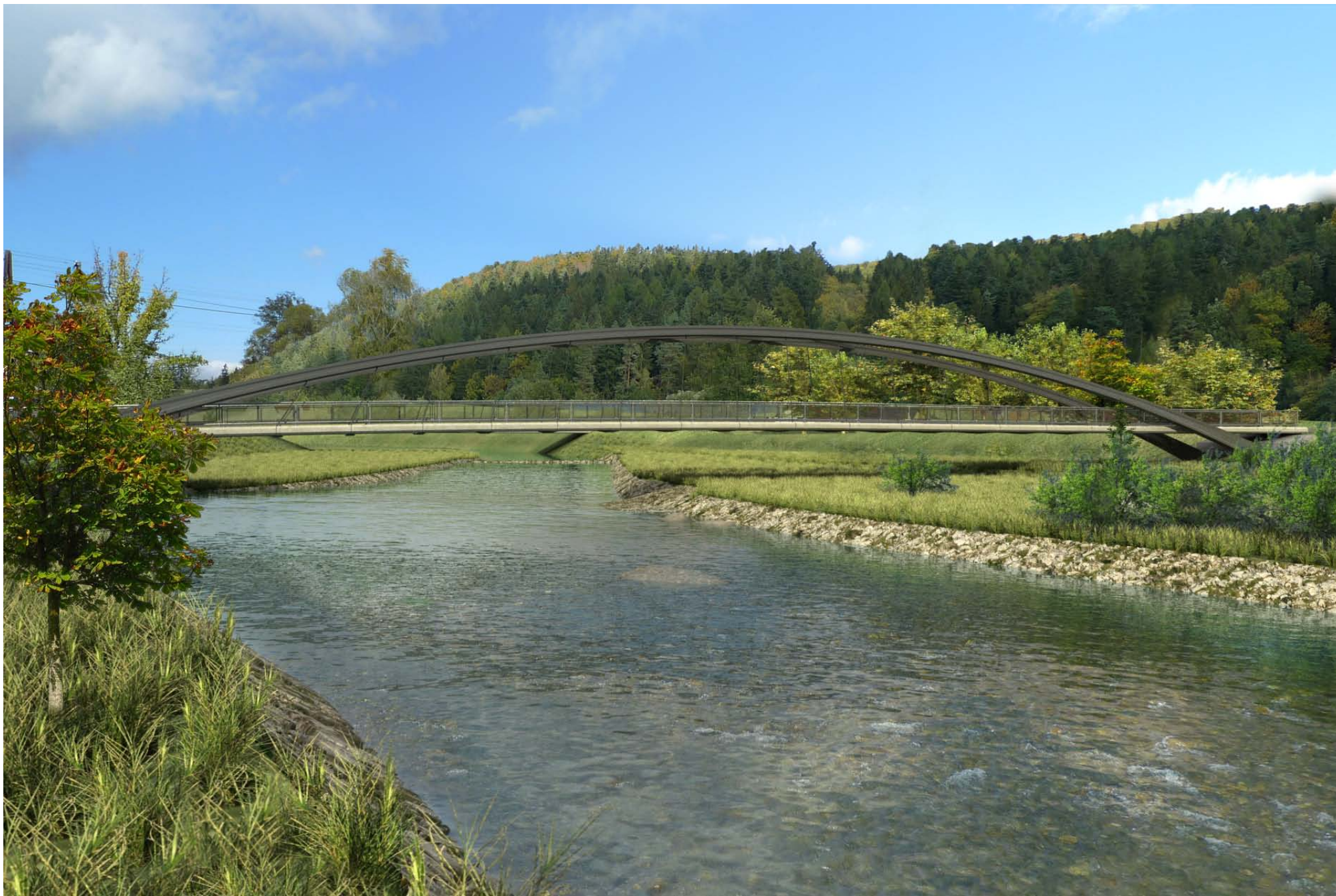
Obec Nové Heřminovy, pohled proti vodě na prostor obloukového mostu (km 88.940 dle TPE) - po realizaci navrhovaných opatření
