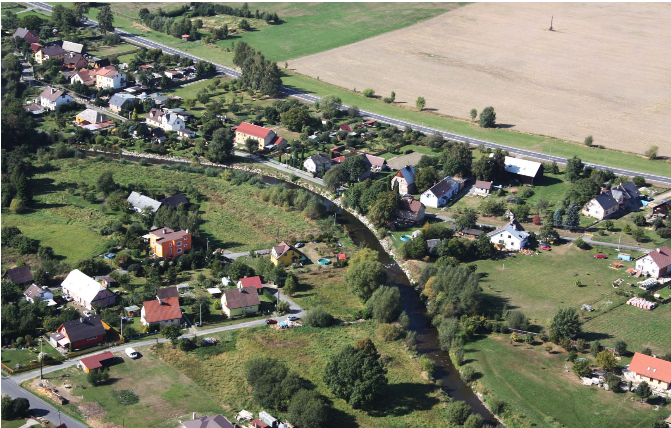
Obec Zátor, letecký pohled proti toku na úsek mezi silničním mostem v km 82.510 dle TPE a revitalizací v dolní části obce - současný stav
