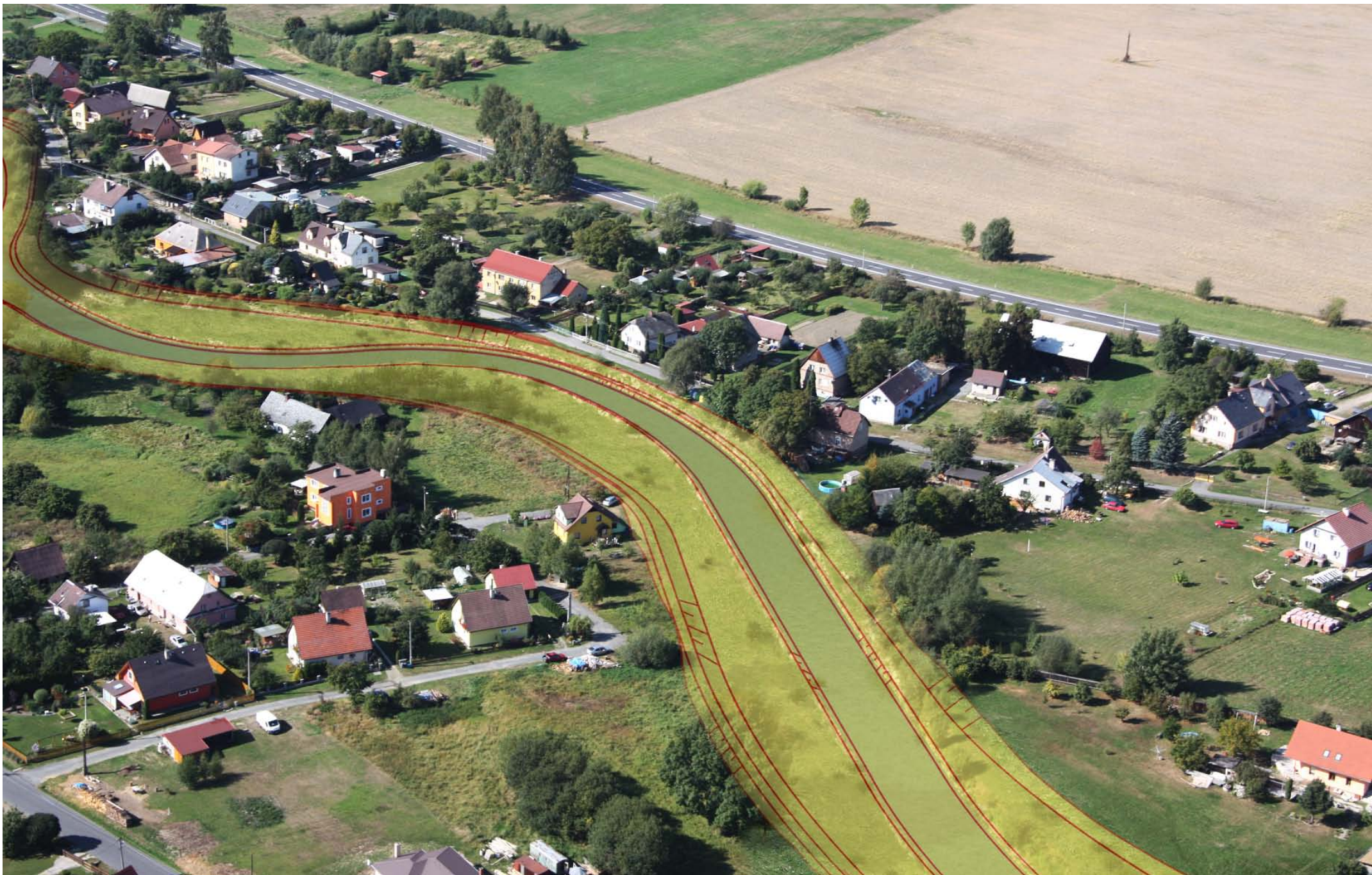
Obec Zátor, letecký pohled proti toku na úsek mezi silničním mostem v km 82.510 dle TPE a revitalizací v dolní části obce - po realizaci úprav
