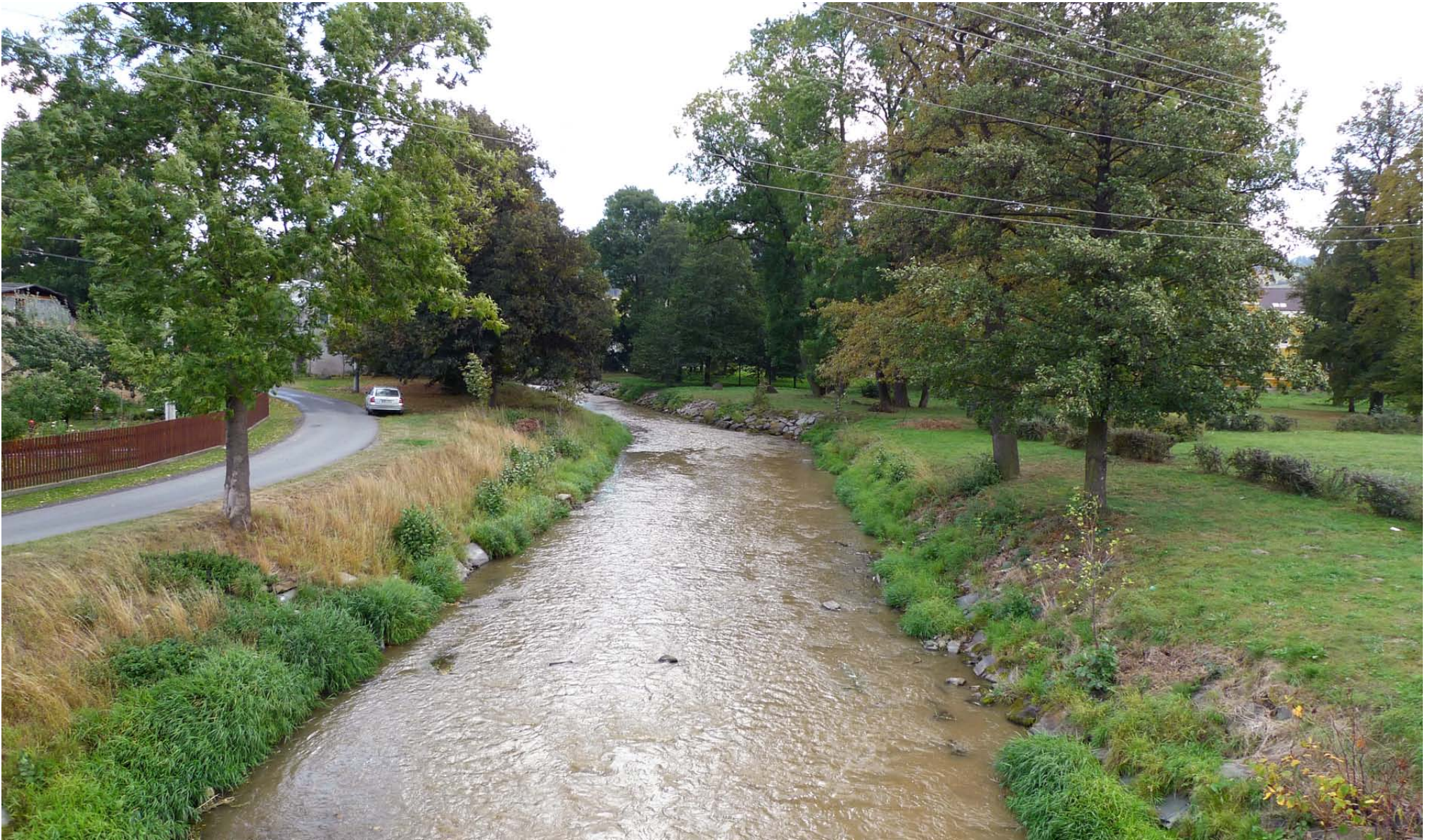
Obec Zátor, pohled po toku z mostu v km 82.510 dle TPE - současný stav
