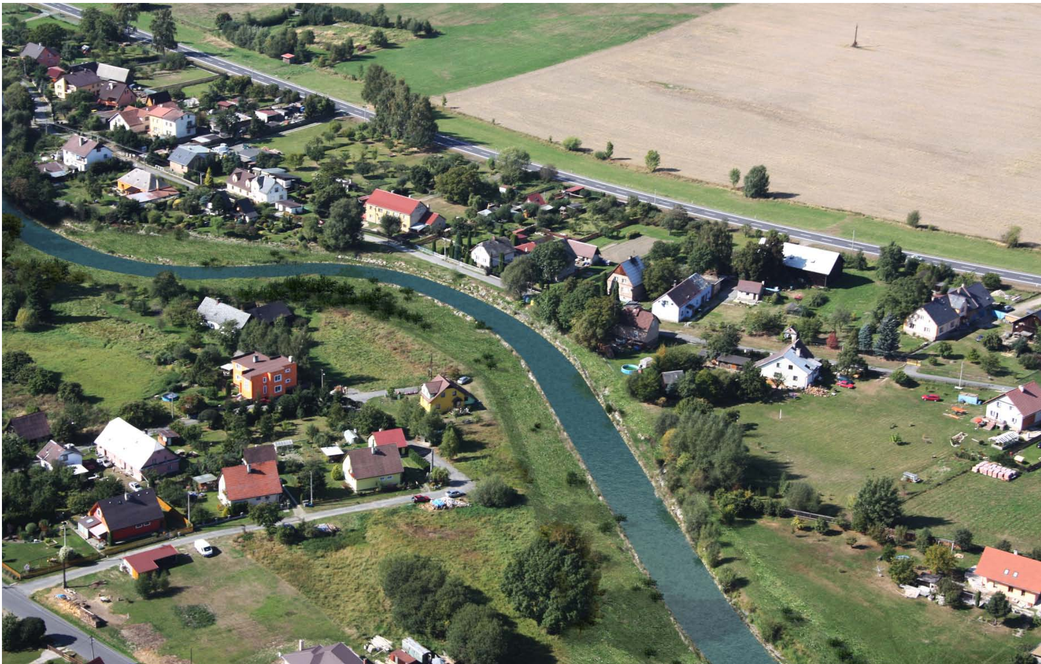
Obec Zátor, letecký pohled proti toku na úsek mezi silničním mostem v km 82.510 dle TPE a revitalizací v dolní části obce - po realizaci úprav
